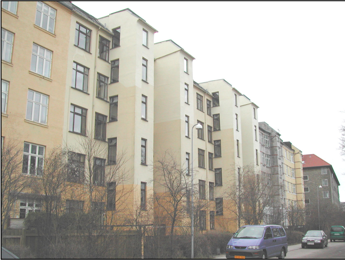
Figur 1: Bagfacaden på Hostrupsvej 12-14.
